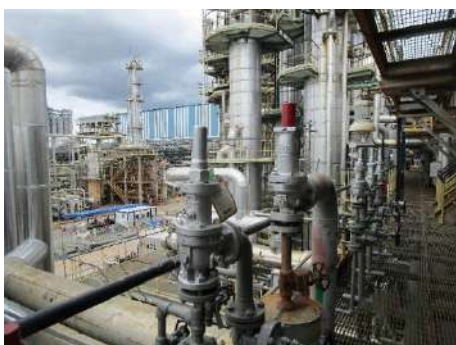
ภาพที่ 2.2-36 วาล์วตัดแยกระบบ (Manual Isolation Valve หรือ Emergency Isolation Valve)
