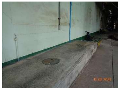
ภาพที่ 2.2-5 ระบบบำบัดสำเร็จรูป (SATs) และบ่อรวบรวมน้ำเสียจากอาคารสำนักงานของโรงกลั่นน้ำมัน
