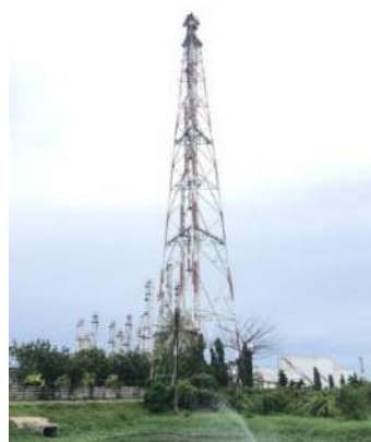
ภาพที่ 2.2-3 หอเผาที่ระดับเหนือพื้นดิน (Elevated Flare)
