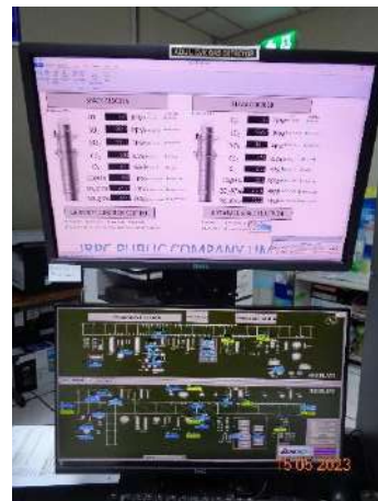
ภาพที่ 2.2-33 ระบบ Distributed Control System (DCS)
