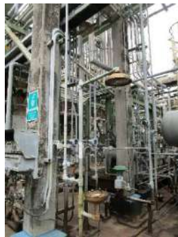
ภาพที่ 2.2-32 ฝักบัวฉุกเฉิน (Emergency Shower) และที่ล้างตา (Eye Washer)
