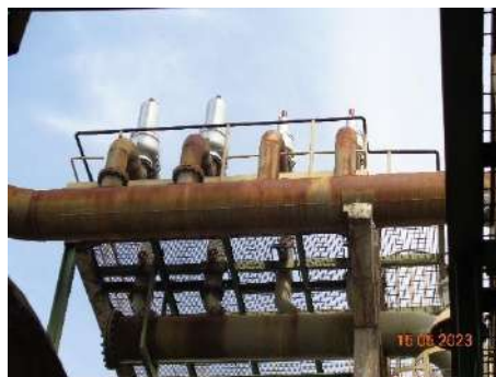
ภาพที่ 2.2-34 ระบบ Double Safety Relief Valve
