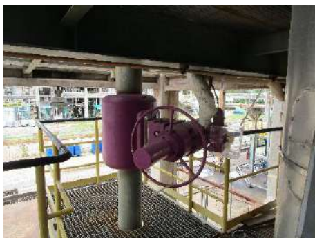
ภาพที่ 2.2-36 วาล์วตัดแยกระบบ (Manual Isolation Valve หรือ Emergency Isolation Valve)
